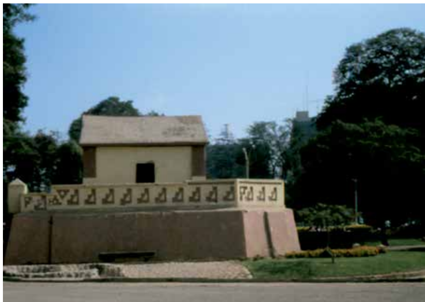
PARQUE DE LA RESERVA 1926-1929. de arriba abajo, de izquierda a derecha: 1) Parque de La Reserva - Paseo principal desde la galería (1994). 2) Parque de La Reserva - Escultura en rotonda principal (1994). 3) Parque de la Reserva - Pabellón Inca. Fotografías: Wiley Ludeña Urquizo.
